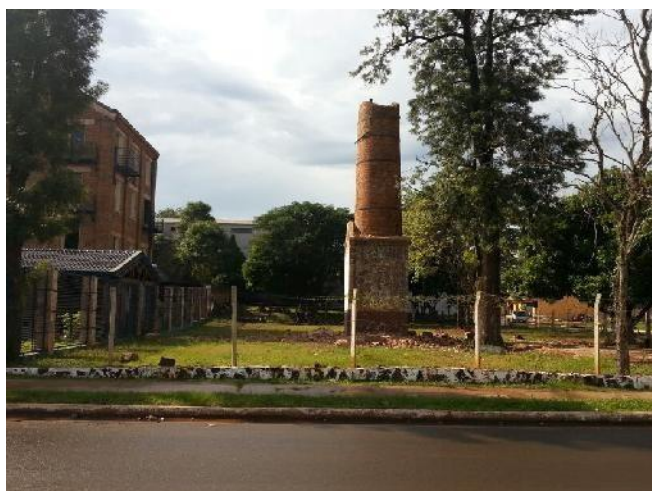
Chimenea de la Sodería Oreggioni (en proceso de demolición durante el conflicto)
