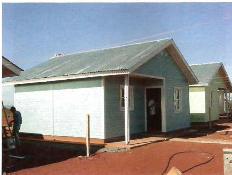
Figura 4.37. Vista de dos casas terminadas
