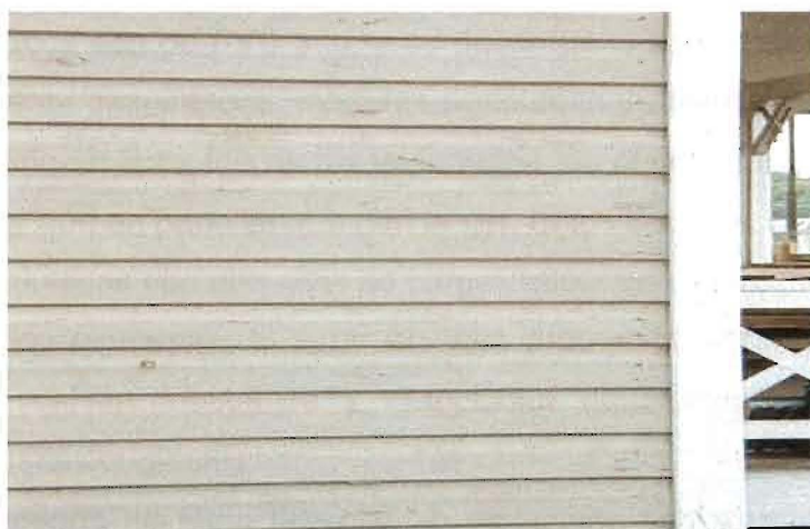
Figura 3.15. Posadas. Pintura al látex texturable. Pared Este
