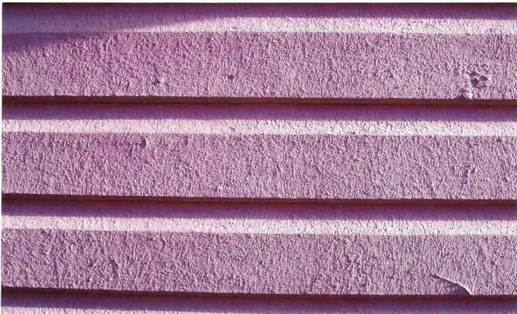
Figura 3.13. Posadas. Pared Sur, pintada con látex texturable
