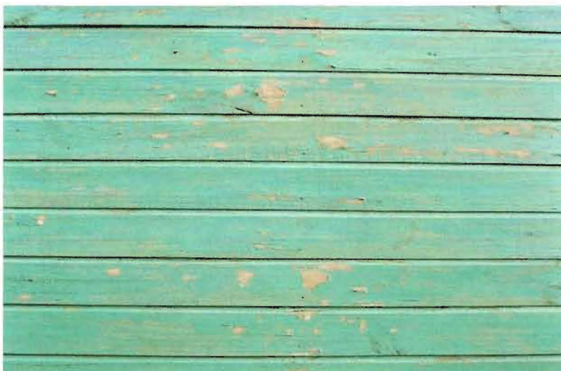
Figura 3.3. Apóstoles. Pared Este repintada con esmalte sintético
