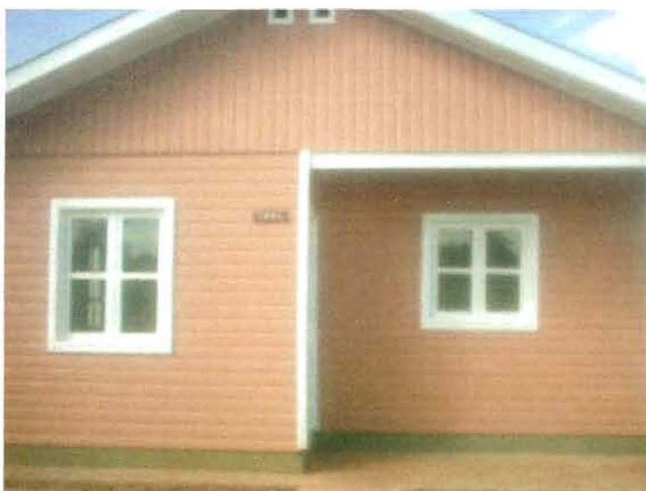
Figura 4.39. Vista de una casa terminada
