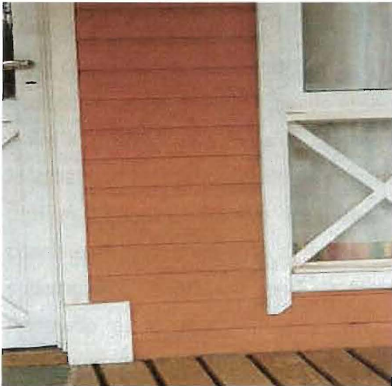
Figuras 3.16.(a) y (b). Posadas. Pintura al látex texturable. Pared norte bajo galería (izquierda). Pared norte, expuesta (derecha)
