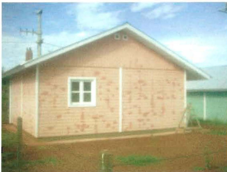
Figura 4.38. Parches con una mano a pincel de pintura para cubrir el aluminio
