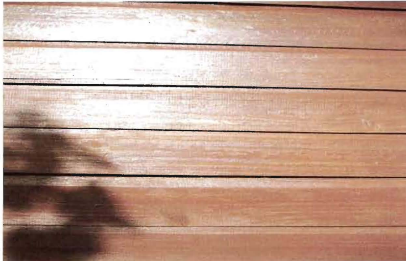
Figura 3.2. Apóstoles. Pared norte repintada con esmalte alquídico
