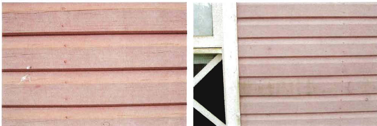
Figura 3.14. (a) y (b). Posadas. Pintura al látex texturable, pared este (izquierda). Pared sur (derecha)
