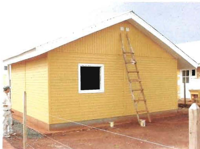
Figura 4.35. Se aprecia la pintura final de la vivienda
