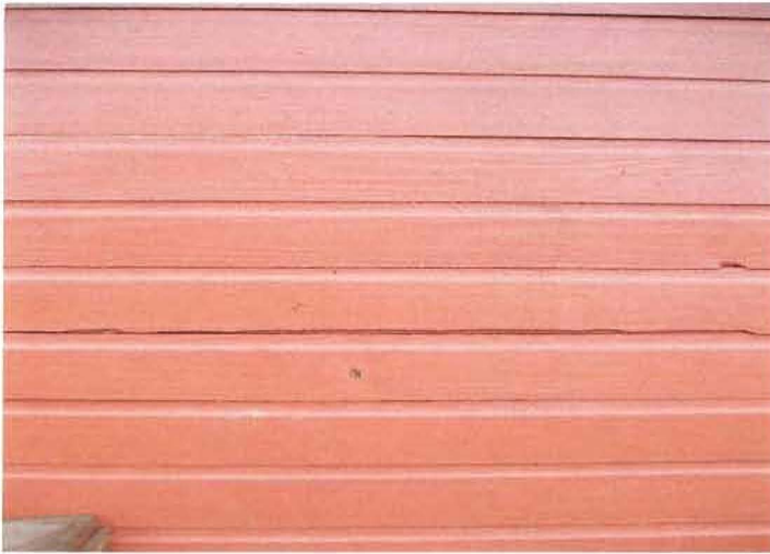
Figura 3.4.a. San Javier. Pared sur pintada con esmalte alquídico
