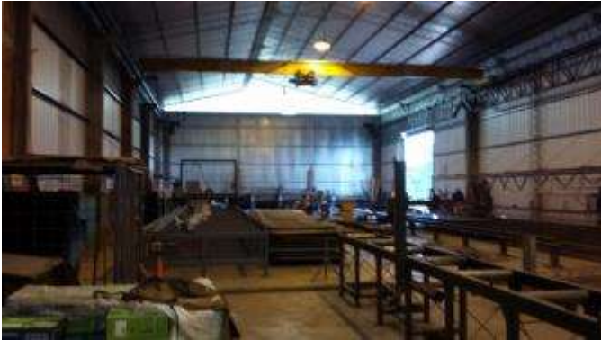
Fotografía N° 8: armadora de estructuras metálicas
