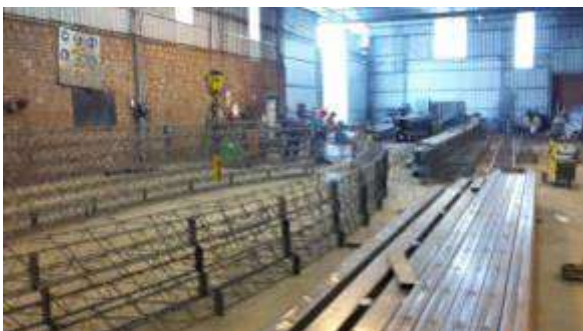
Fotografía N° 7: material en proceso de limpieza, pintura, etc..
