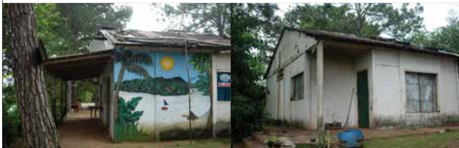
Ex-Destacamento de Prefectura de Santa Ana. Localidad de Santa Ana. 1976.
