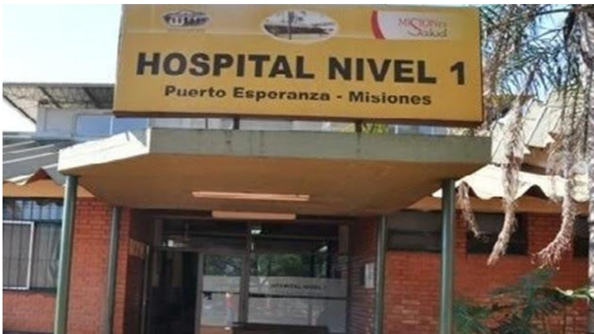
FIGURA 2. INGRESO PRINCIPAL DEL HOSPITAL NIVEL 1 DE PUERTO ESPERANZA. Fuente: Melina Gonzalez.
