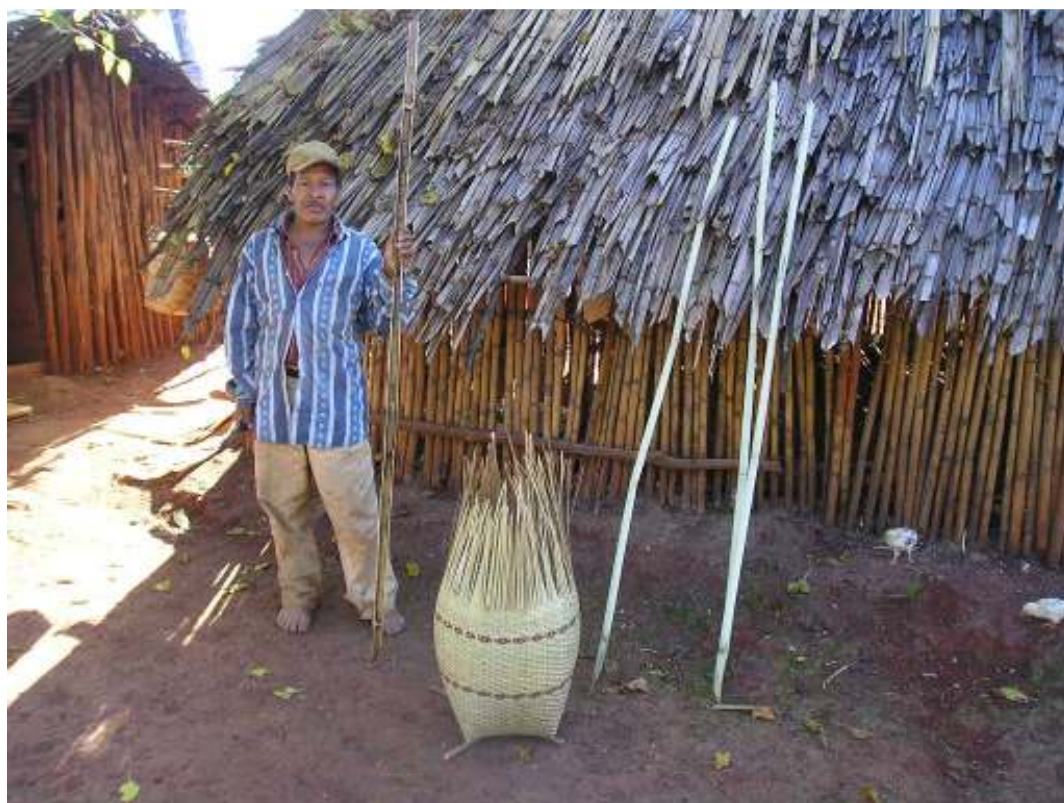
Confección de un cesto para la venta. Obsérvese el tejado y las paredes de la casa construidos con cañas takuapi .
