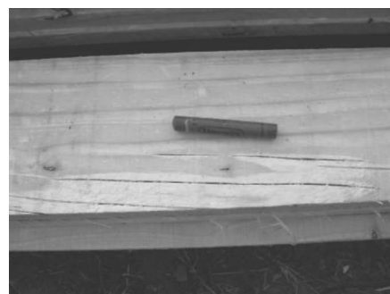
Fotos 1 y 2: Rajaduras radiales en el 4 to anillo de crecimiento en ejemplar de Pinus taeda en rodal DC11 y tabla afectada por las mismas.
