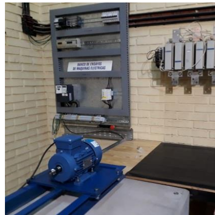
Fig. 2 – Montaje del banco de ensayos
