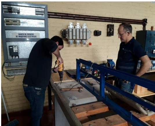
Fig. 1 – Armado del banco de ensayos
