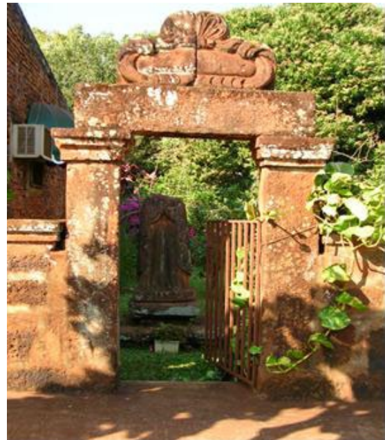
Figura 2. Pórtico con dintel monolítico. Propiedad privada ubicada frente a la plaza principal del pueblo.
