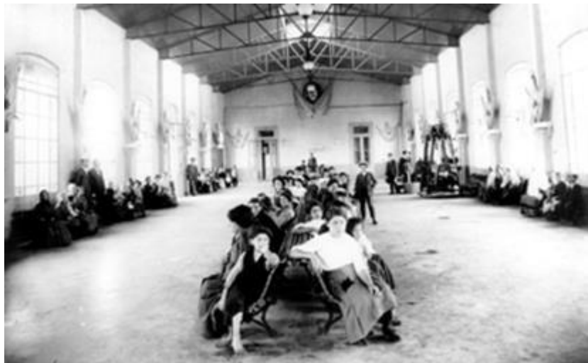
Figura 2. Sala de espera del Hotel de Inmigrantes
