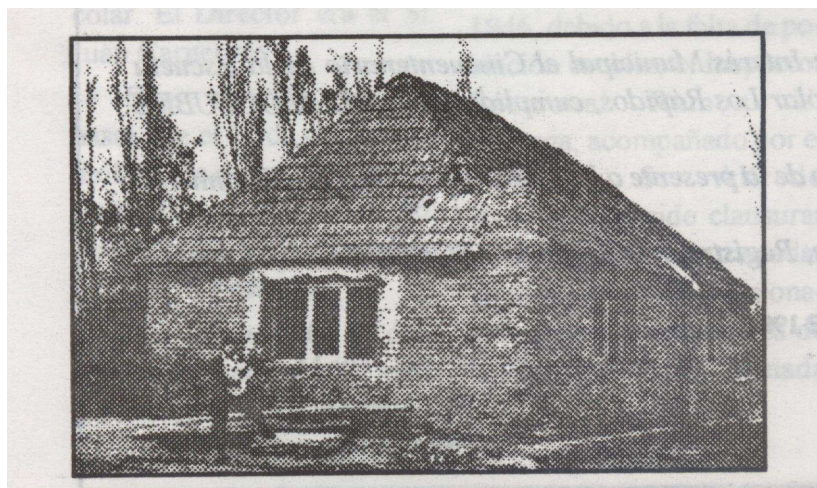
Figura 16: Primer edificio de la escuela N°96 en La Aldea.
