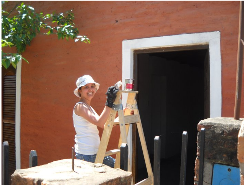
Figura 9: Restauración de frentes en San Pedro Pescador
