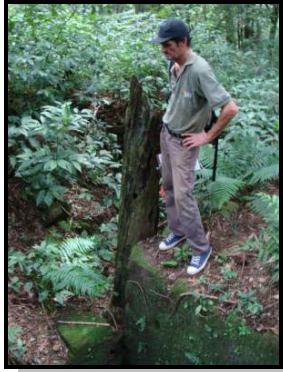
Pilar de madera del colegio
