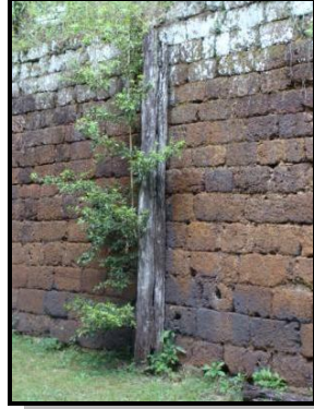
Pilar de madera adosado al muro
