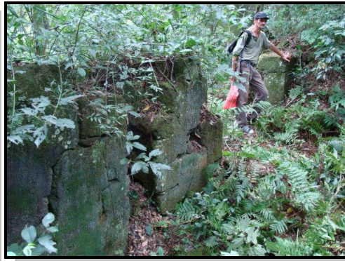
Muros externos del colegio
