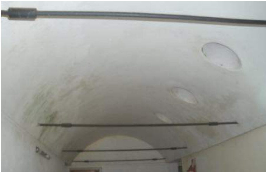
Unidad Sanitaria de El Soberbio. Detalle bóvedas y tensores, interior
