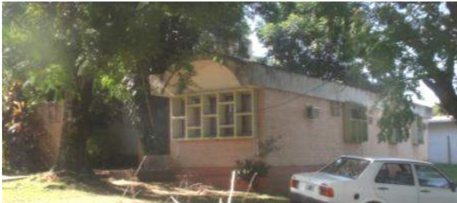
Unidad Sanitaria de El Soberbio. Vista de conjunto
