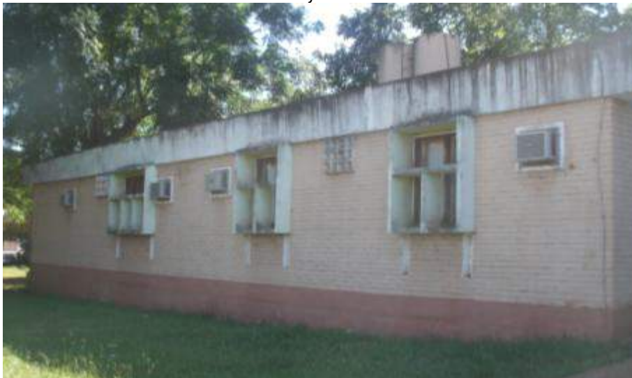
Unidad Sanitaria de El Soberbio. Vista lateral
