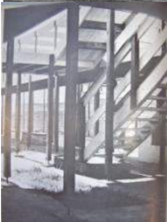
Vista galería y dormitorios
