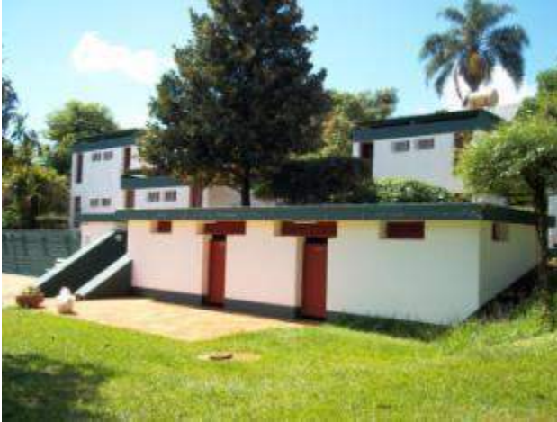
Vistas desde sector de piscina
