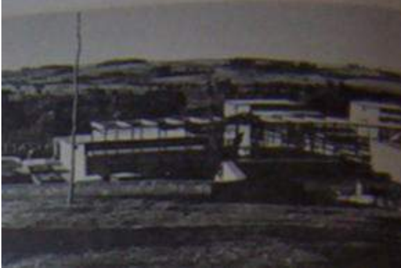
Vista galería y dormitorios
