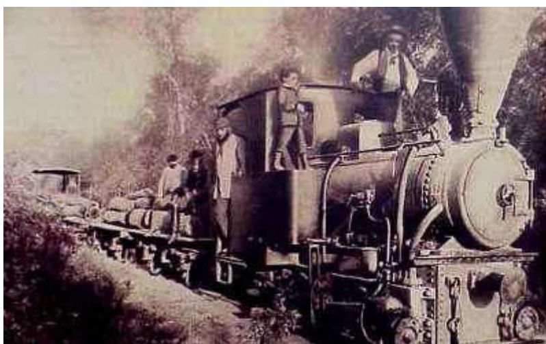
Foto N° 5. Fuente: < http://www.lagazeta.com.ar/laforestal.htm > [ Fecha de consulta 22/11/11]
