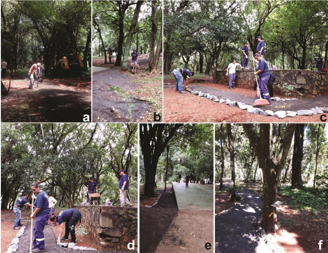
Figura 10. Construcción de los senderos. a – b. Descarga de Binder sobre el terreno. c - d. Compactación de los senderos y delimitación con piedras de basalto. e. Sector del sendero de mediana dificultad en construcción. f. Sector del Sendero de baja dificultad en etapas finales de construcción.
