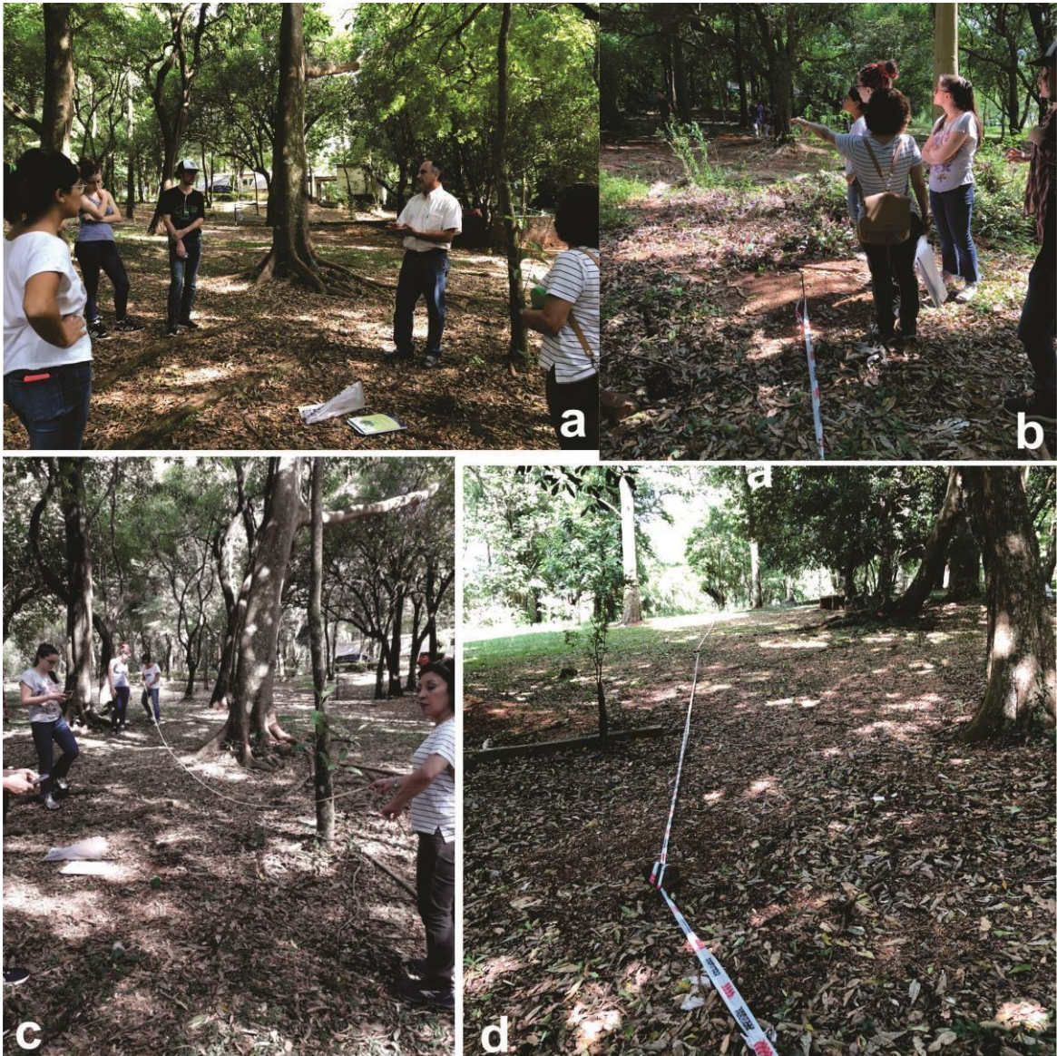
Figura 8. Delimitación de los senderos. a-b. Identificación de las curvas de nivel en correspondencia con la pendiente. c-d. Delimitación preliminar con cintas, ramas y piedras.
