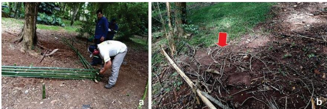
Figura 3. Taller el abordaje del problema de la erosión en el Jardín Botánico Alberto Roth. a. Armado de la represa de control. b. Resultado en el transcurso del tiempo y evidencias de la acumulación de materia orgánica.
