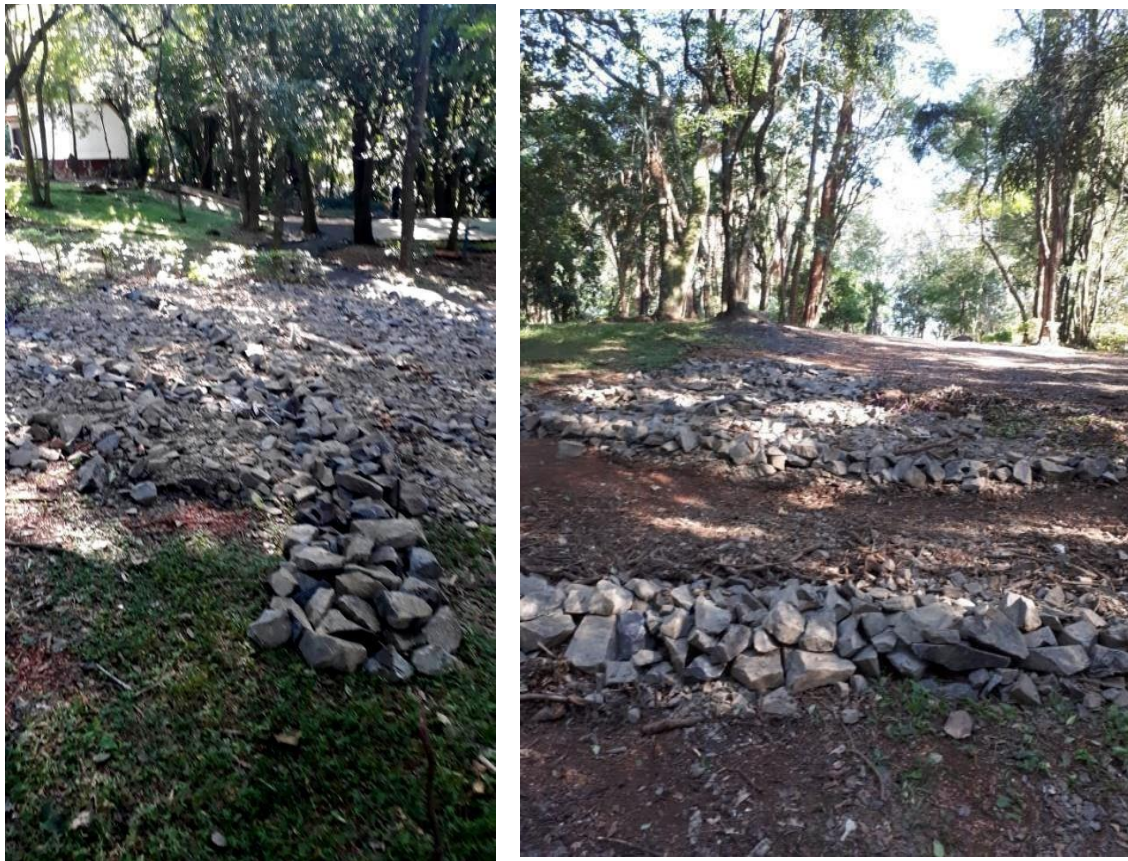
Figura 7. Barreras de piedra (basalto) en curvas de nivel.
