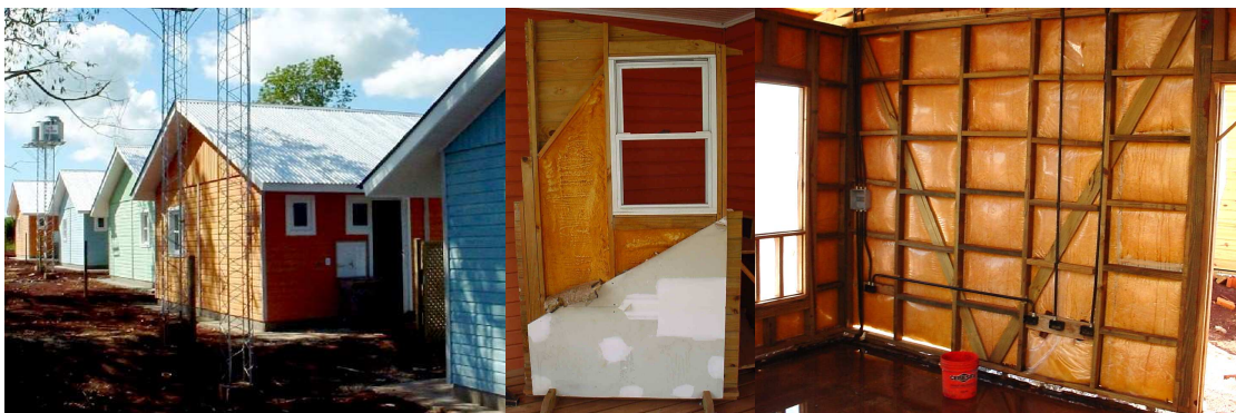
Foto 1 Viviendas de madera construidas en la actualidad con aislación de lana de vidrio y/o espuma poliuretano. (35) (CELANO 2004)
