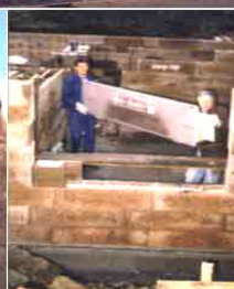
Foto 7 Bloques de construcción madera cemento OKO-DOMO. (30) Holzbau 2004
