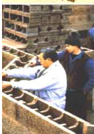
Foto 7 Bloques de construcción madera cemento OKO-DOMO. (30) Holzbau 2004
