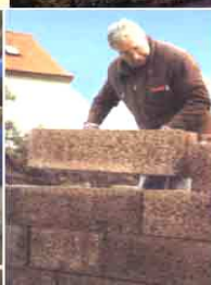
Foto 7 Bloques de construcción madera cemento OKO-DOMO. (30) Holzbau 2004
