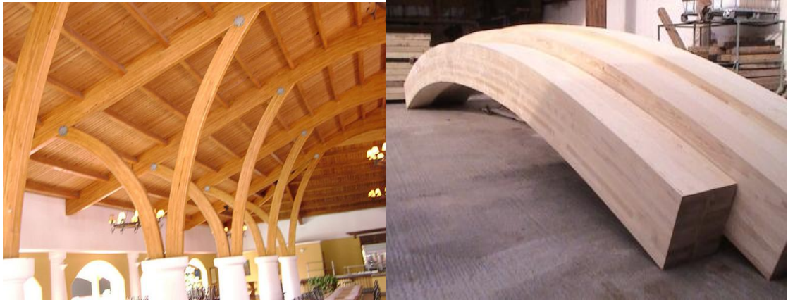
Foto 1: Estructuras construidas con vigas laminadas de madera
