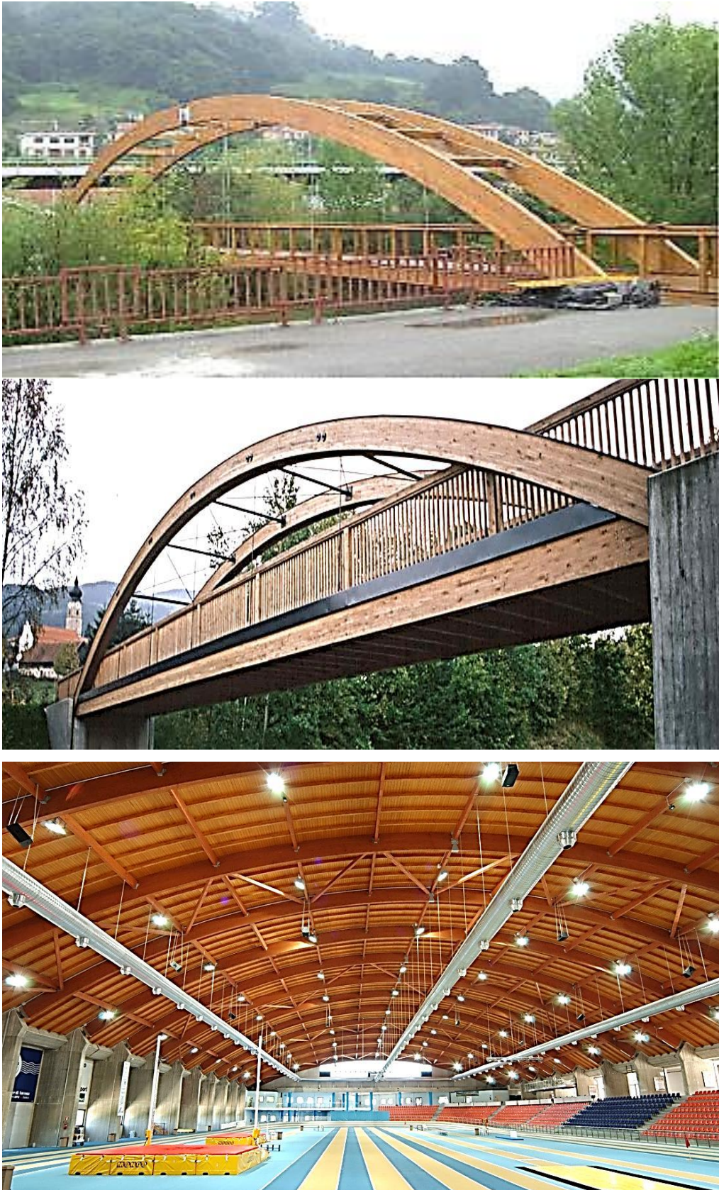
Foto 5: Estructuras construidas con vigas laminadas de madera
