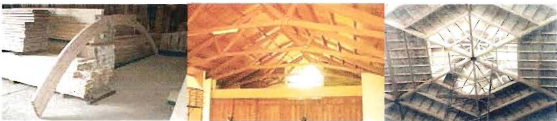
Foto 8: Viga multilaminada curvada, vigas laminadas y maciza en techos.
