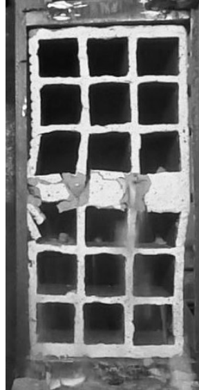
Figura 6.6. Ensayo a compresión: fallas en celda 11.-
