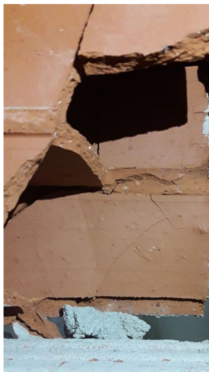
Figura 7.29. Fallas locales interiores en el panel para ensayo CCBF.
