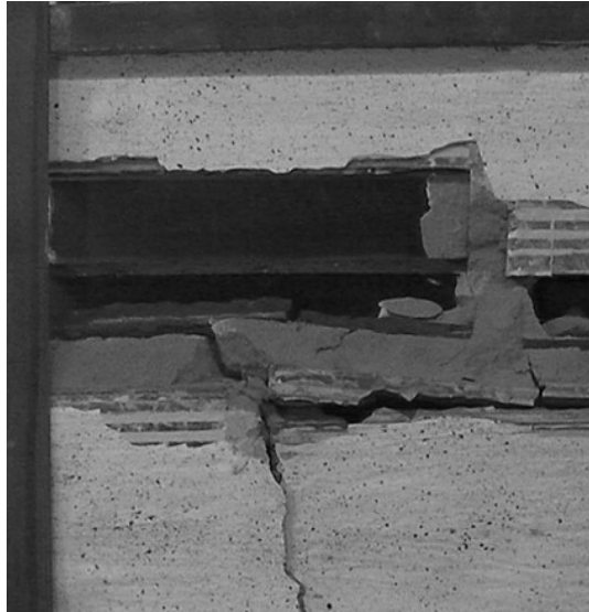
Figura 6.12. Ensayo a compresión: fallas en celda 17 lateral.-
