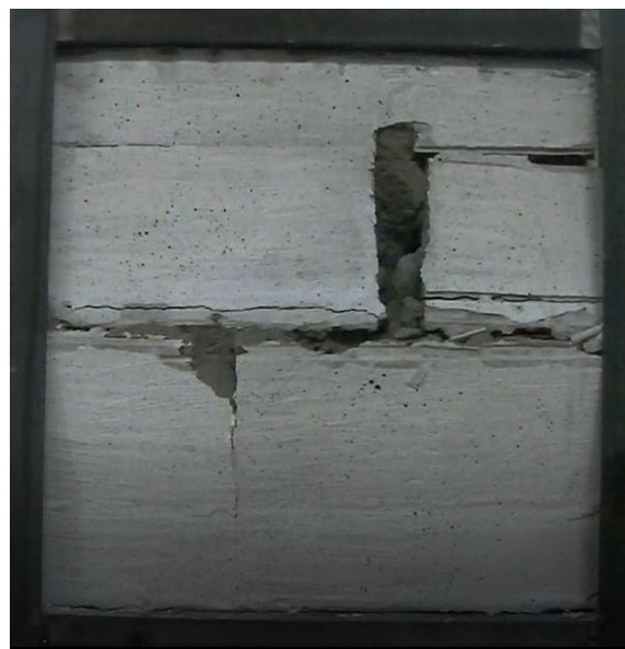
Figura 6.8. Ensayo a compresión: fallas en celda 1 lateral.-
