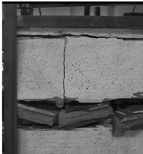
Figura 6.10. Ensayo a compresión: fallas en celda 14 lateral.-
