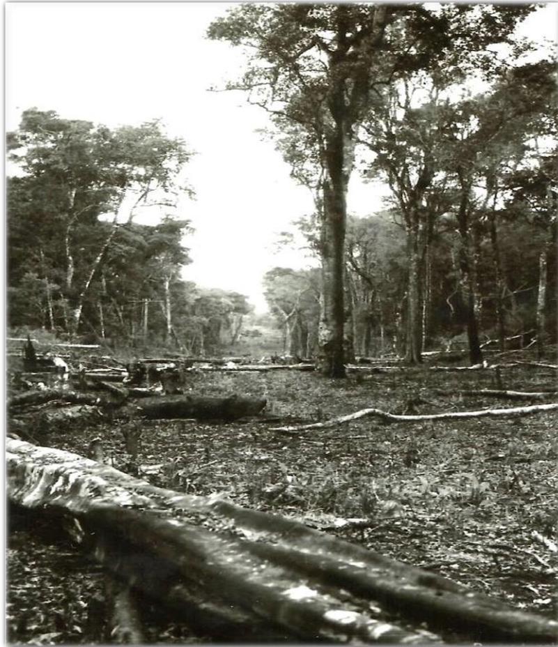
Imagen 28: Desmonte para la apertura de la picada maestra en el km 11 de Eldorado (c. 1921)
