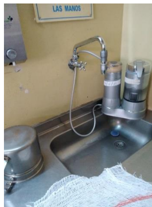
Fotografía N°24: Sistema de Filtro de Agua potable para su uso en la preparación de FL.
