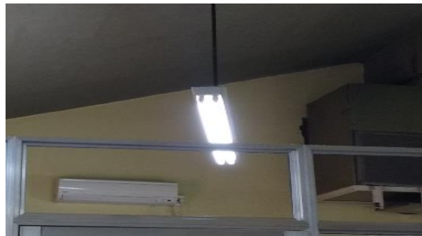
Fotografía N°16: Iluminación artificial sin protección en zonas de Limpieza y fraccionamiento.
