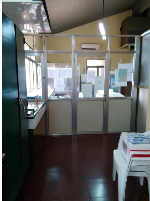
Fotografía N°50: Separación entre áreas deficiente, iluminación sin protección.
