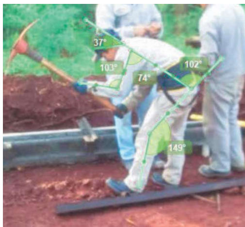
Figura 1- Operario 1 en la posición de análisis y ángulos identificados para aplicar el método REBA. Actividad de colocación de moldes metálicos.
