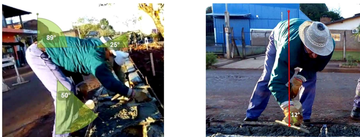
Figura 5- Operario en la posición de análisis y ángulos identificados para aplicar el método REBA. Actividad de alisado y terminación.
