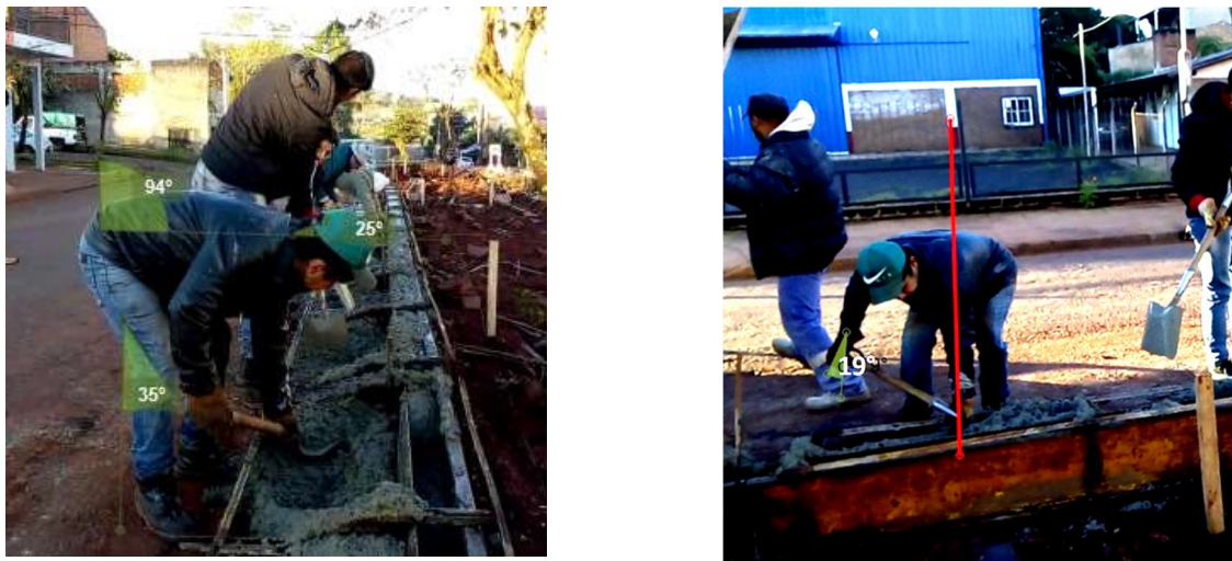
Figura 3- Operario en la posición de análisis y ángulos identificados para aplicar el método REBA. Actividad de colocación de hormigón en moldes.
