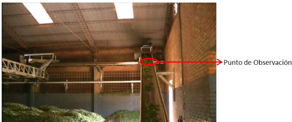
Figura 4: Cinta transportadora de materia prima entre Recepción y Conservado
