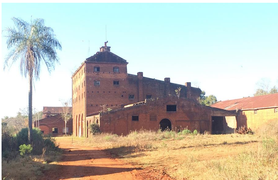
FIGURA 7: Edificio para secado de yerba mate.
