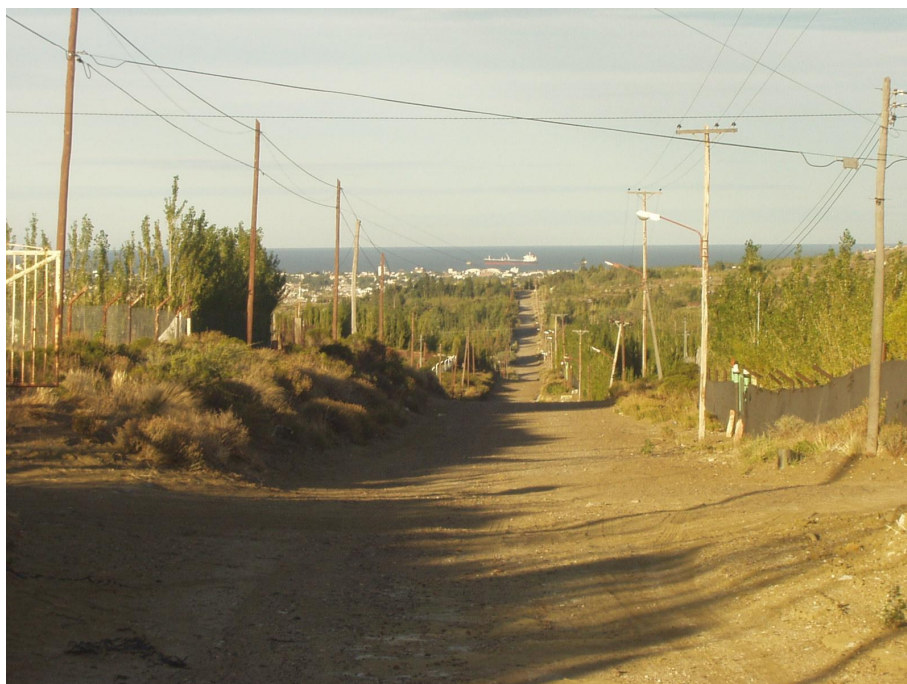
Vista desde el Oeste en dirección Sureste. Avenida principal, en el fondo Caleta Olivia y océano atlántico.
