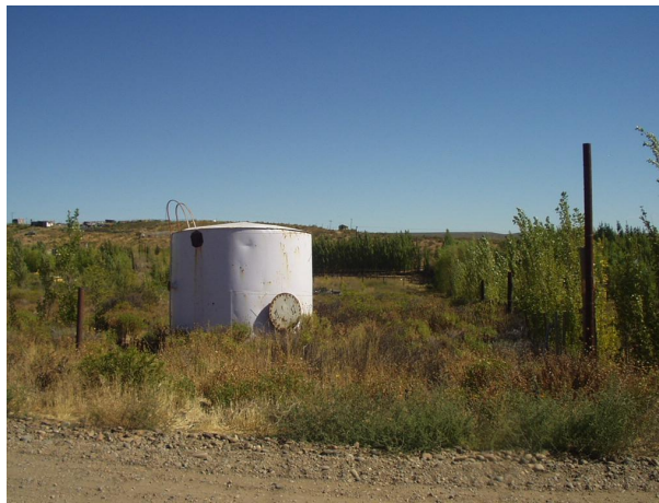
Sistema de almacenamiento con tanques de industria petrolera reutilizado en la unidad de tenencia
