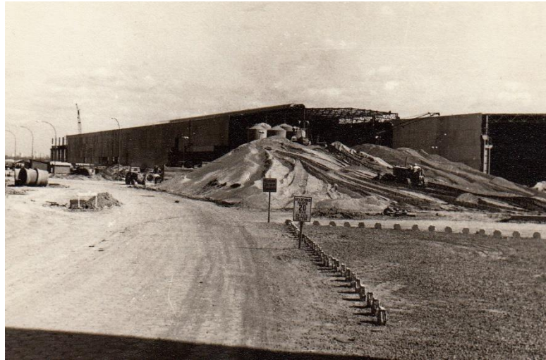
Fuente: Imágenes de la construcción de Propulsora Siderúrgica- Descargada de la página de facebook “Veteranos de Propulsora Siderúrgica”
